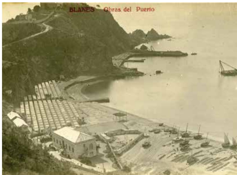
Obres de construcció del port. 1918 c. Foto Núm. Reg. 18.139. Col·lecció Ramona Robert Balvey (AMBL)
