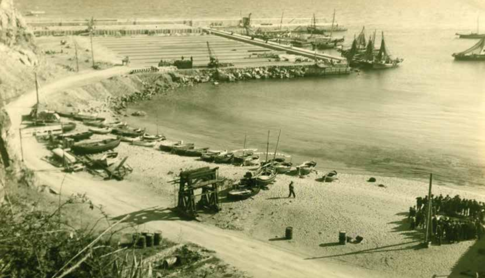
Les obres del port. A la dreta, moment de la subhasta del peix. Anys trenta. Núm. Reg. 6.722. Fons Francesc Salt (AMBL)
