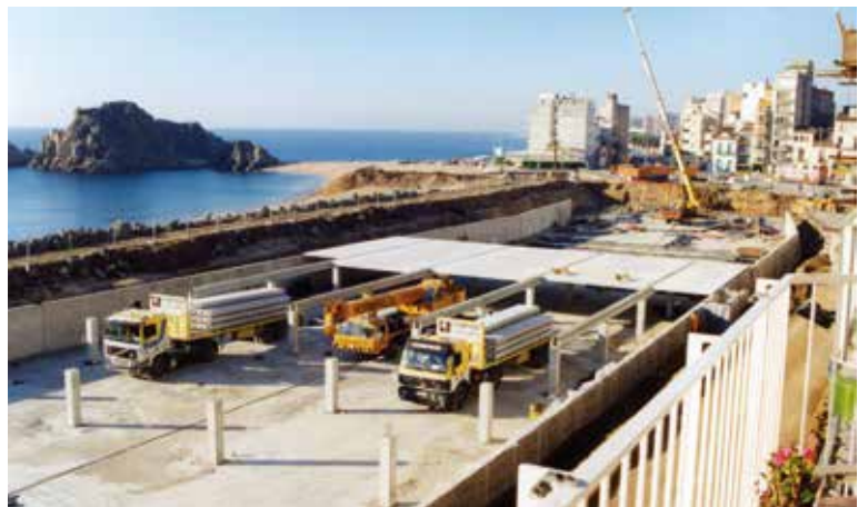
Construcció de l'aparcament soterrani del passeig. 1993. Foto Antoni Reyes (AMBL)
